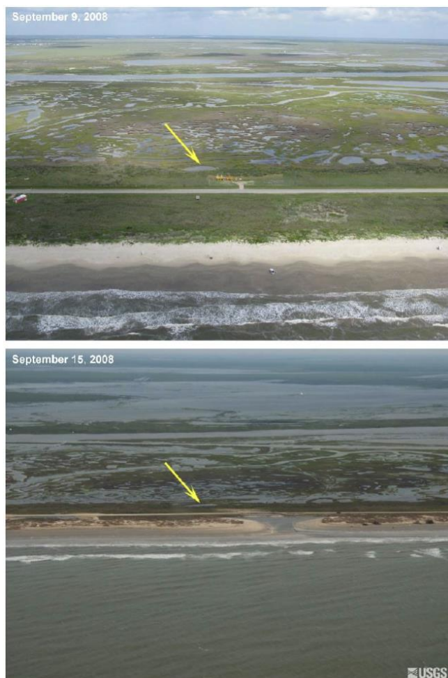
Figure 2.39 Résidences côtières dans le village de Surfside qui ont été endommagées et détruites par l'ouragan Ike (les résidences sont les éléments orange sur l'image du haut). L'image montre l'ampleur de l'érosion le long d'une partie de la côte de Surfside. L'érosion côtière causée par une tempête a déplacé la végétation vers l'intérieur des terres, ce qui a fait que des résidences se sont retrouvées sur des terres publiques. Au Texas, les terres publiques sont définies comme la zone située entre la laisse de basse mer et la ligne de végétation (USGS 253 ).
