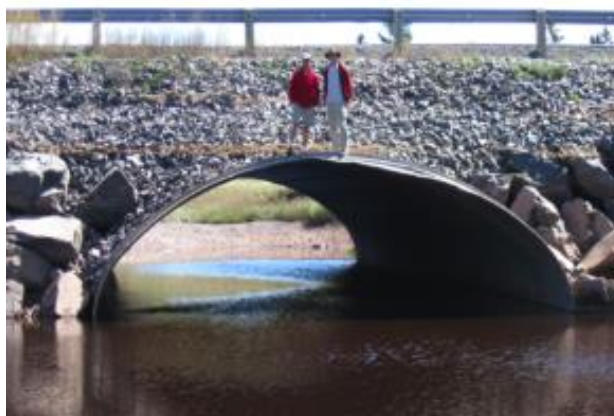
Figure 1.14 Ponceau du ruisseau Cheverie, Cheverie (N.-É.) (Tony Bowron, CBWES Inc.).
