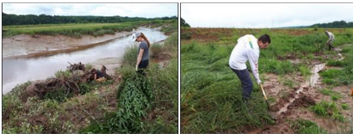
Figure 1.26 Pratiques de gestion adaptative mises en œuvre sur le site de réalignement de Belcher Street, 2019 (1.26a à gauche : creusement manuel de rigoles; 1.26b à droite : réparation du littoral vivant; TransCoastal Adaptations: Centre for Nature-Based Solutions)
