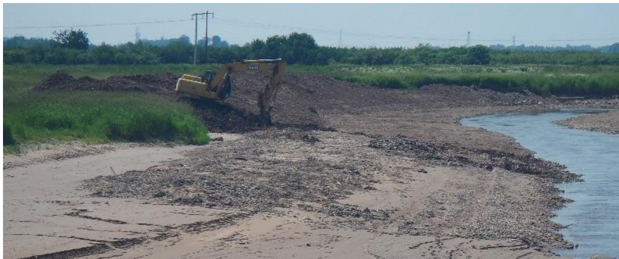
Figure 3.22 Dragage par excavation mécanique d'un petit chenal à Salmon River, en N.-É. (Graeme Matheson, Université Saint Mary's)
