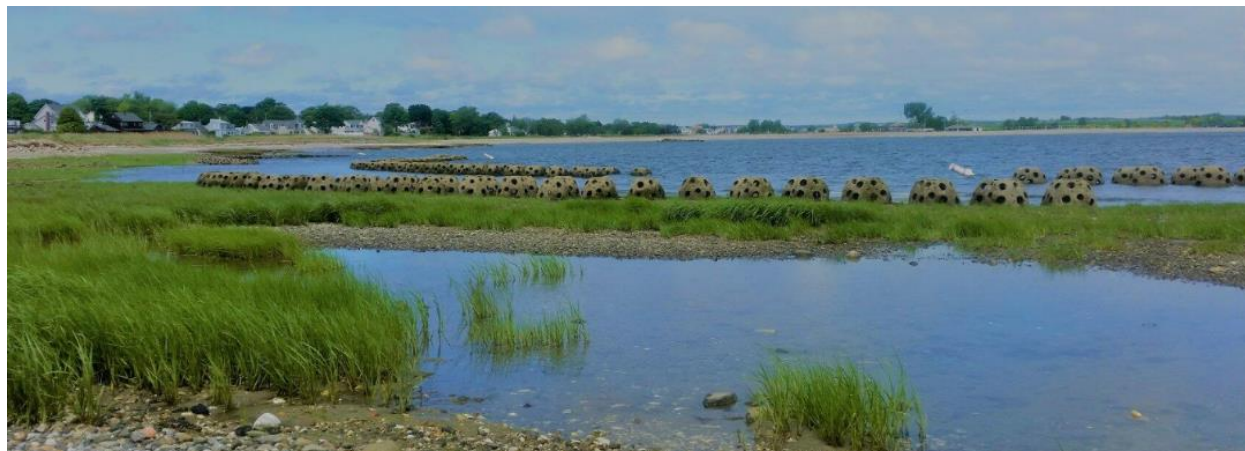
Figure 3.38 Installation de sphères récifales en béton le long de Stratford Point (National Audubon Society Inc., 2020)
