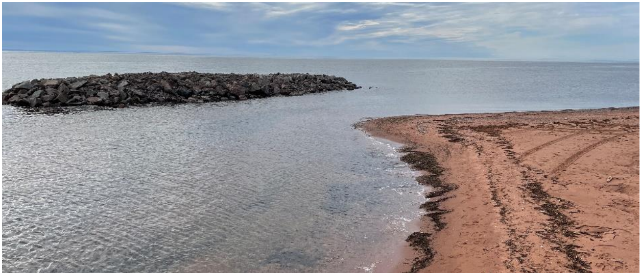
Figure 3.16 Brise-lames visant à atténuer l'érosion à West Point, à l'Î.-P.-É. (Vincent Leys, CBCL Limited)
