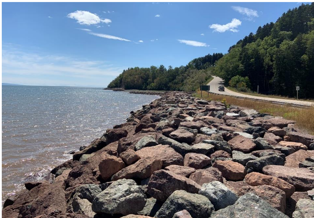
Figure 3.11 Revêtement combiné à des structures de stabilisation de plage au parc national Fundy, au N.-B. (Vincent Leys, CBCL Limited)
