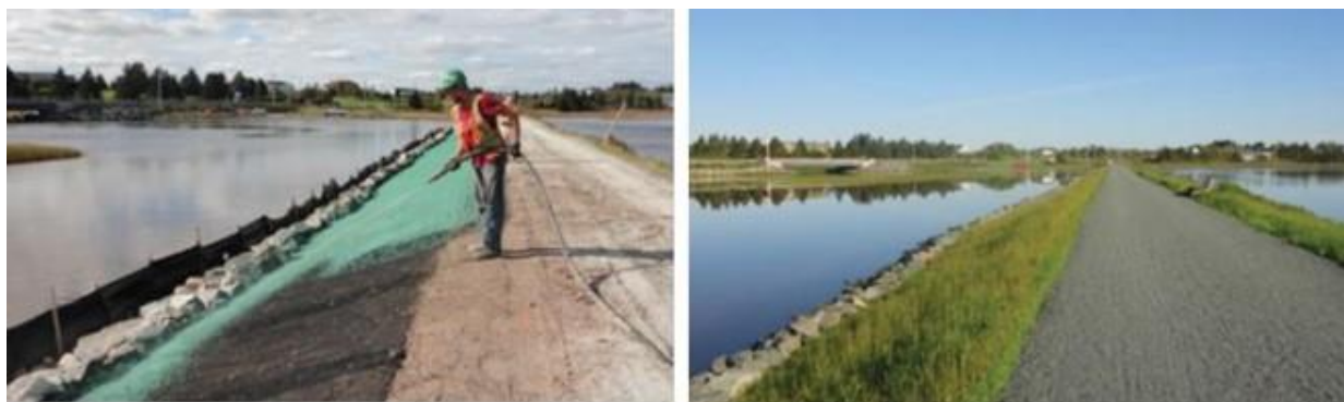
Figure 3.5 Installation d'un tapis de renforcement du gazon avec pierres à la base jusqu'au niveau du sentier riverain près de Lawrencetown Beach (N.-É.). Le tapis est rempli de paillis au moyen d'un système hydraulique (à gauche) choisi en fonction des conditions du site.
