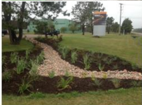
Figure 3.50 Installation d'une zone de bio-infiltration au parc industriel de Debert (Tracey MacKenzie, 2015)
