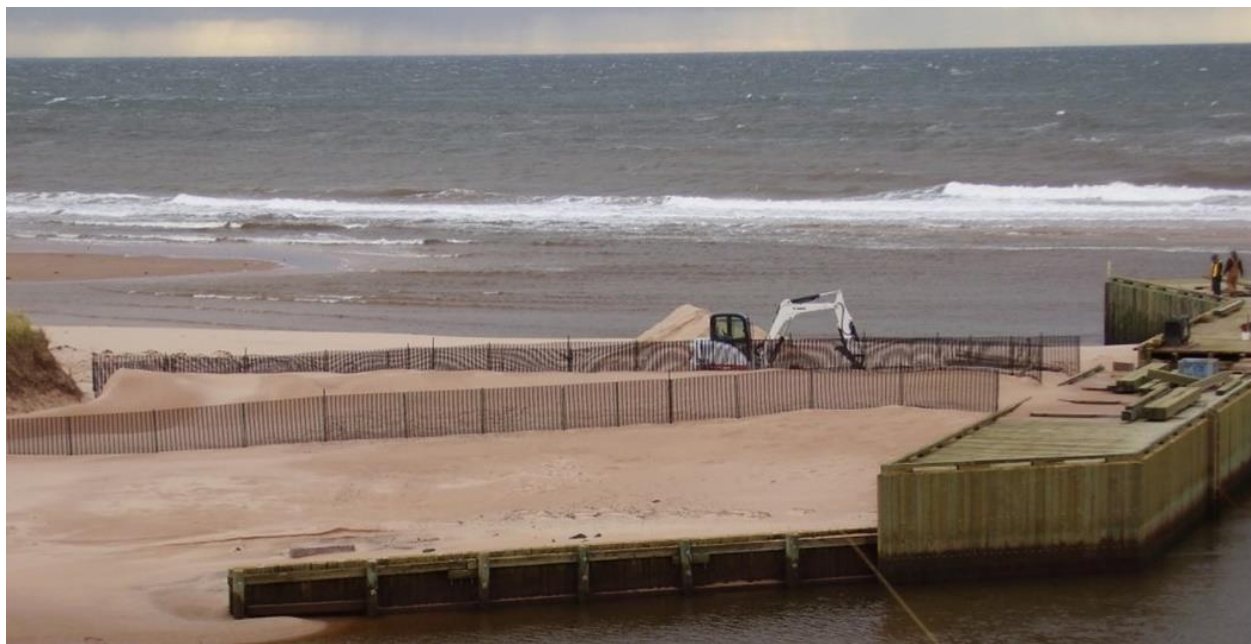
Figure 3.6 Restauration de dunes pendant la construction d'un revêtement enfoui à Basin Head (Î.-P.-É.) (Jody MacLeod, CBCL Limited)
