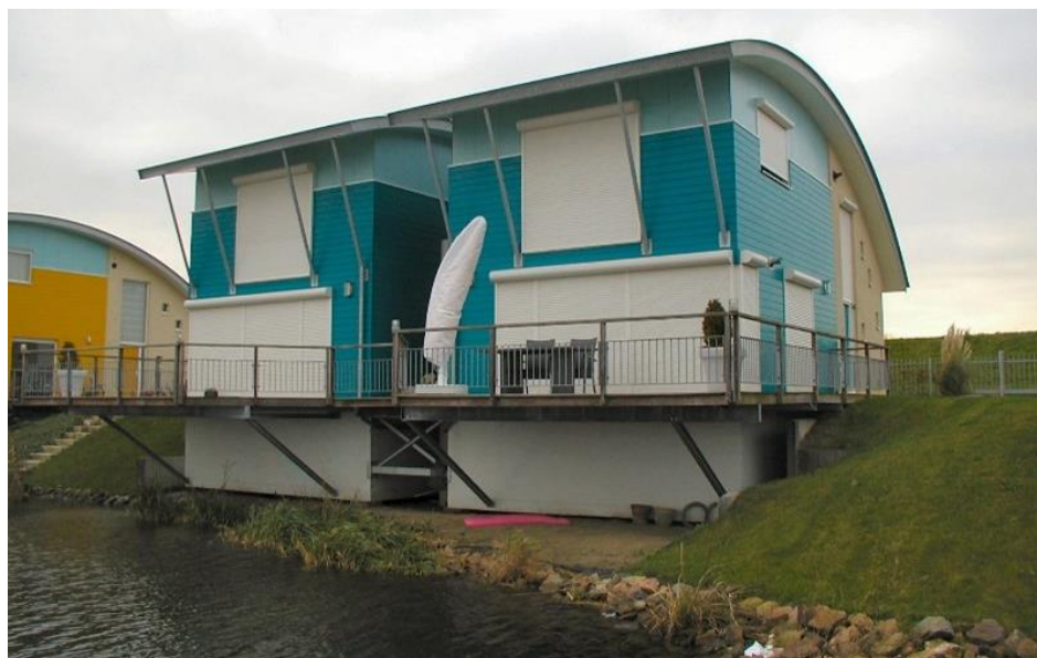
Figure 3.27 Maison à fondation amphibie en Hollande (Dura Vermeer)
