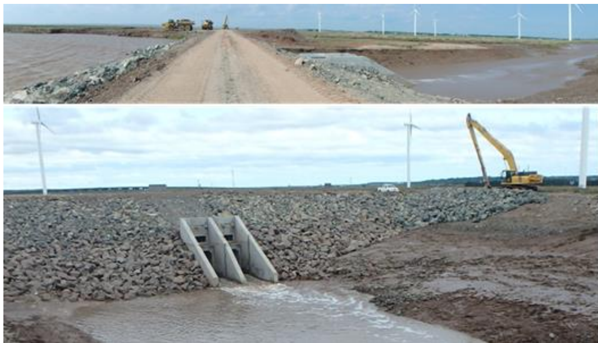
Figure 3.44 Aboiteau de la rivière La Planche quasi achevé, août 2015 (Suvir Pursnani, CBCL Limited)
