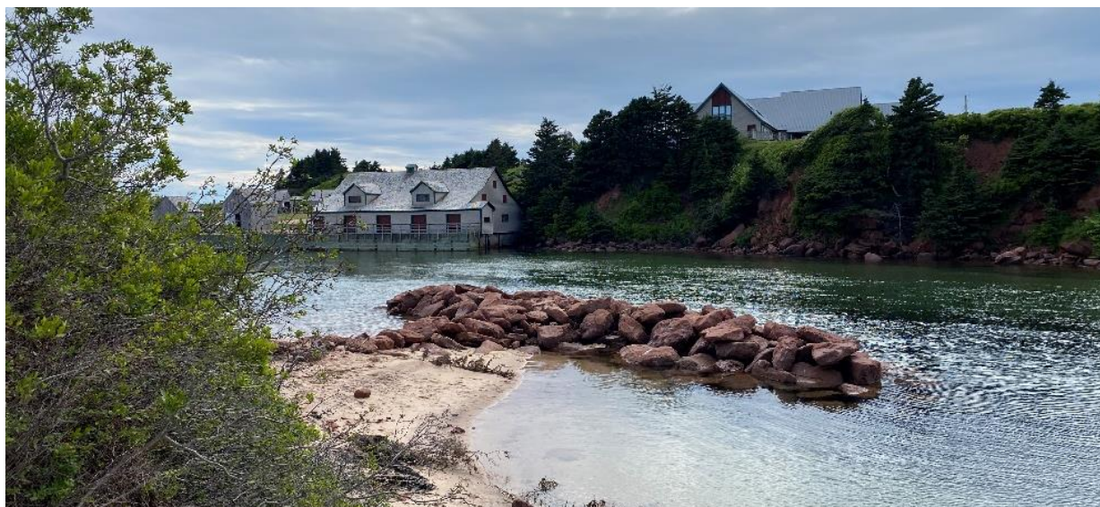
Figure 3.41 Épi en T au parc provincial de Basin Head (Vincent Leys, CBCL Limited)
