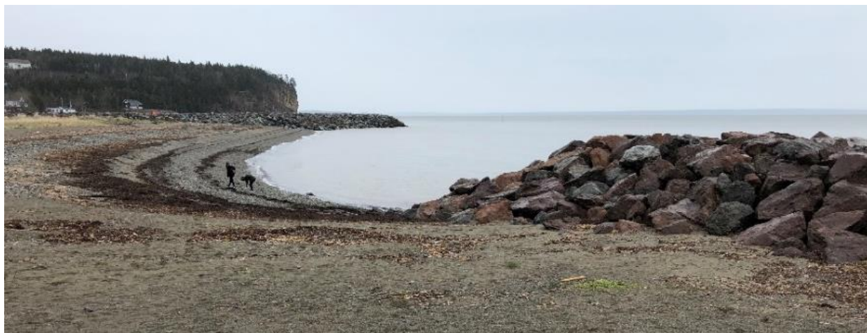
Figure 3.15 Brise-lames de stabilisation de la plage au parc national Fundy, au N.-B. (Vincent Leys, CBCL Limited)
