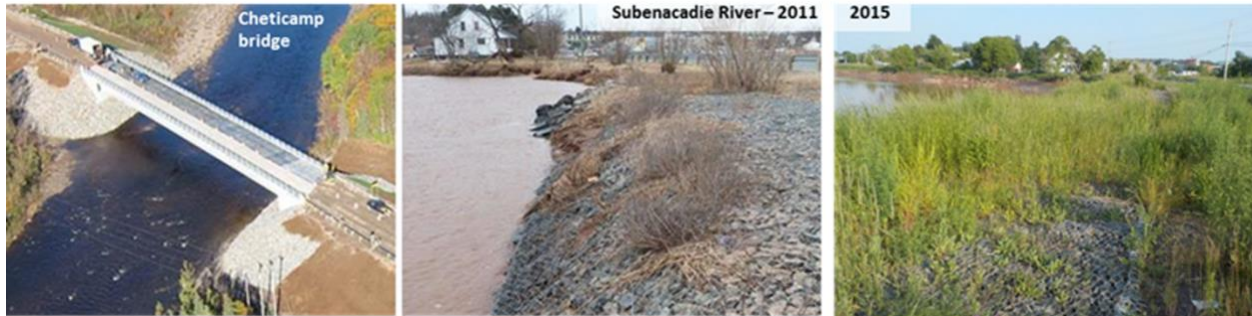
Figure 3.20 Protection contre l'affouillement des piles du pont de Cheticamp à l'aide de pierres (à gauche) et du rivage de la rivière à marées Shubenacadie à l'aide de gabions remplis de pierres (au centre et à droite) (N.-É.).
