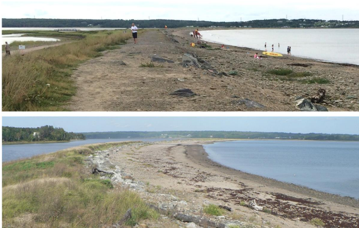
Figure 3.12 Revêtement enfoui à Dominion Beach (N.-É.), deux ans après la construction (en haut), et à Lighthouse Beach (N.-É.), six ans après la construction (Vincent Leys, CBCL Limited)
