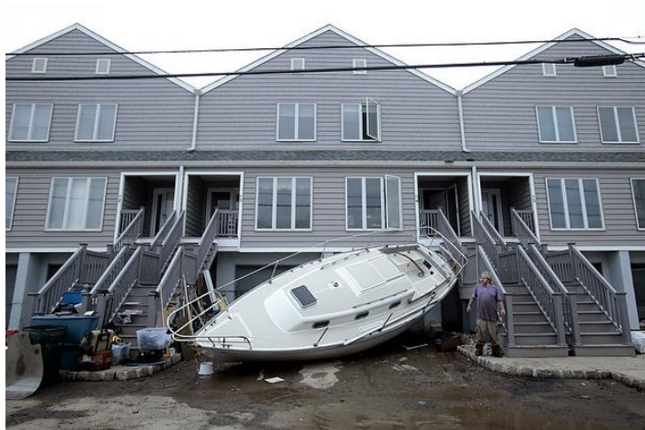
Figure 3.48 L'impact sur ces habitations protégées contre les inondations est minime malgré les impacts majeurs sur les infrastructures du littoral de Sea Bright, comme l'illustre le voilier échoué.
