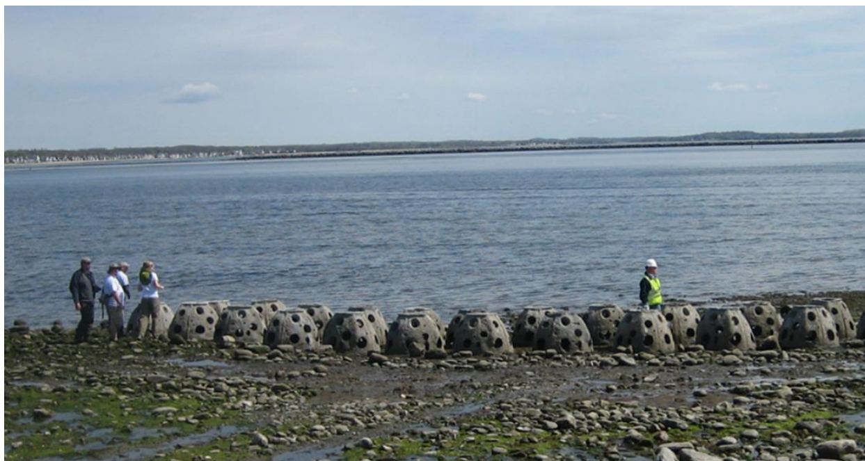
Figure 3.10 Sphères récifales en béton (Paul Stern, 2014)
