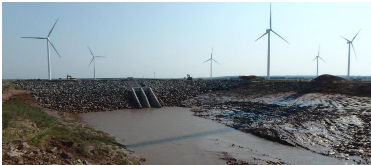
Figure 3.21 Aboiteau à LaPlanche, en N.-É. (Suvir Pursnani, CBCL Limited)
