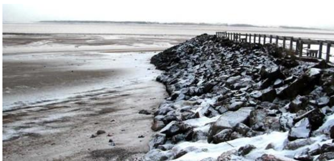
Figure 3.13 Perré à Kingsport (N.-É.), dans la baie de Fundy (Bruce Higgins, CBCL Limited)
