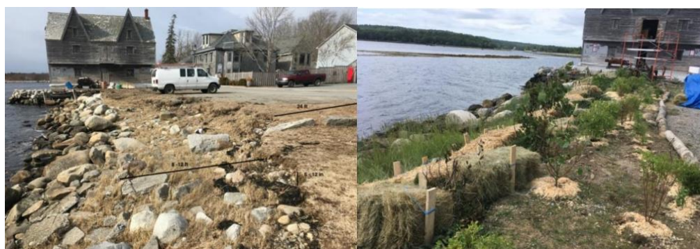
Figure 3.32 Avant (mars 2020) et après (août 2020) l'établissement d'un littoral vivant pour stabiliser la berge (Coastal Action, CBWES)
