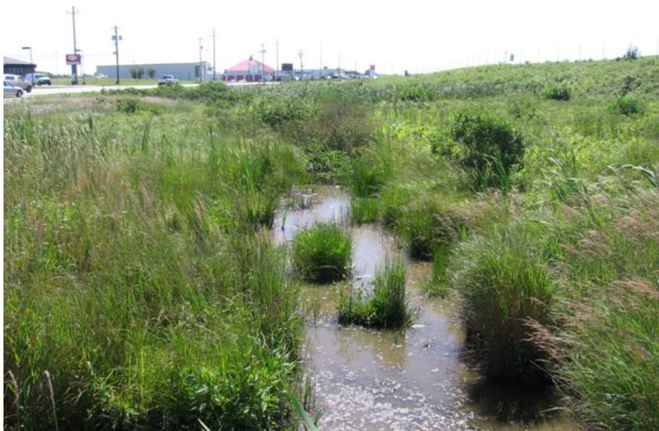
Figure 3.28 Rigole gazonnée à Yarmouth (N.-É.) (Alexander Wilson, CBCL Limited)
